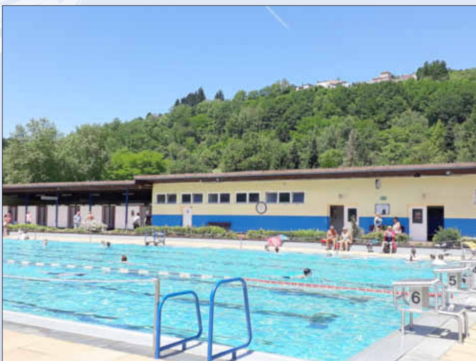
Das beheizte Becken lädt bei jedem Wetter zum Schwimmen ein
