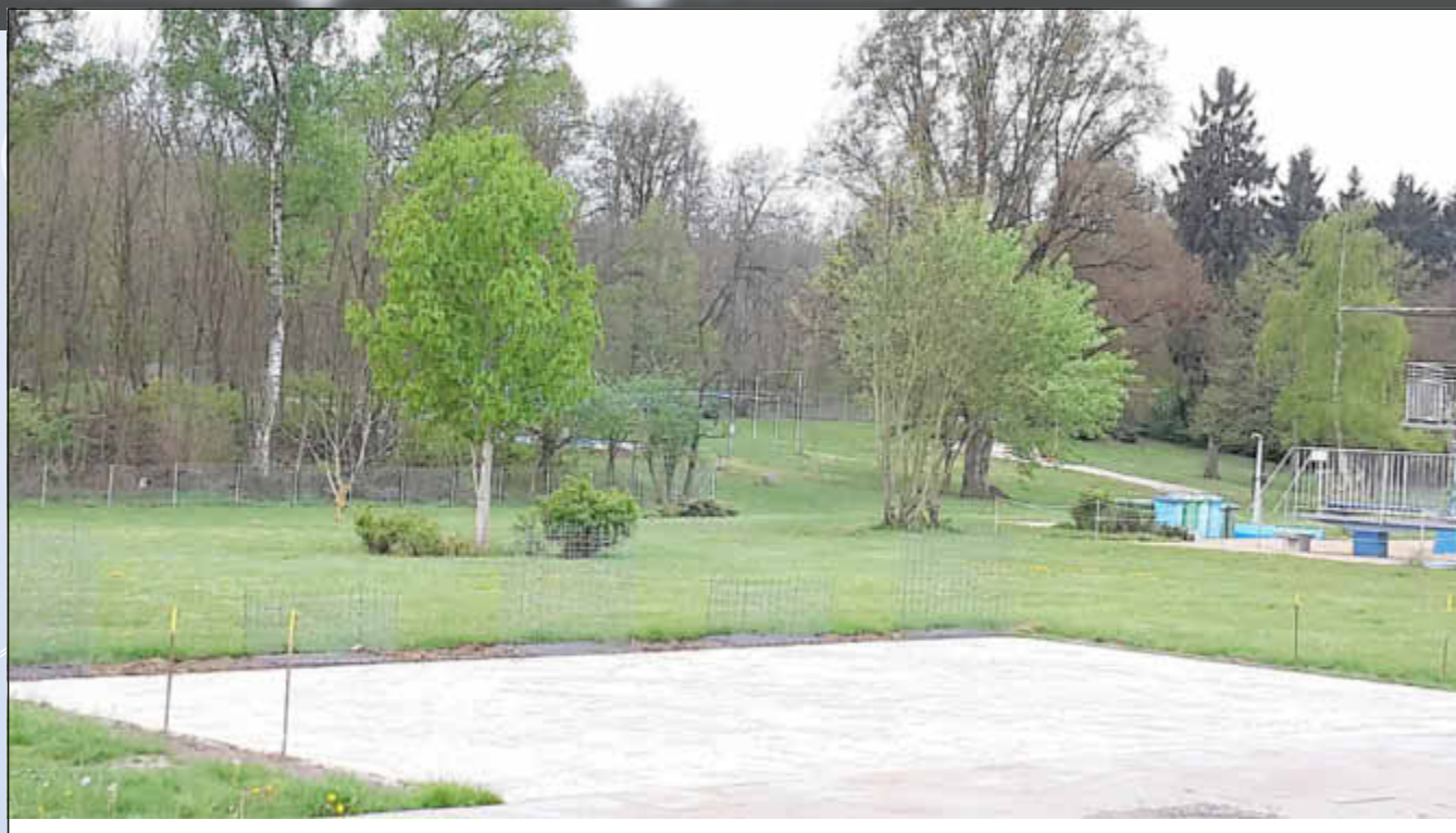
Der neue Biergarten nimmt Formen an
