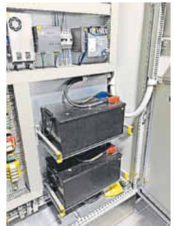
Der in den Akkus gespeicherte Strom sorgt für den Betrieb sämtlicher Beleuchtungsanlagen.
