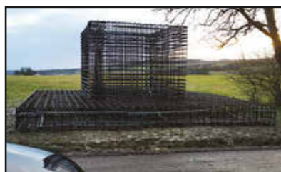
Fundamentarbeiten für den Mobilfunkmast in Ihn
