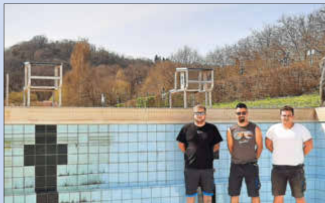
Vorher - Nacher: H. Schramm und sein Team vor der zur Hälfte gereinigten Beckenwand
