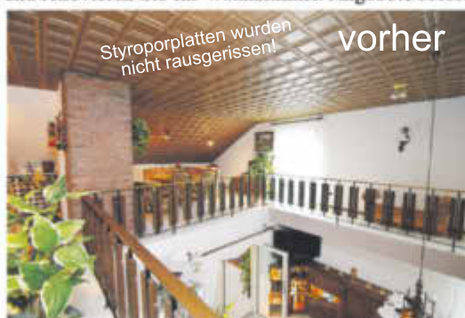
Vorher: Wohnzimmer mit Styroporplatten in Holzoptik. Die Decken waren gut erhalten und konnten somit als Unterkonstruktion wiederverwendet werden. Video zur Baustelle: Schindera.com/Esszimmer
