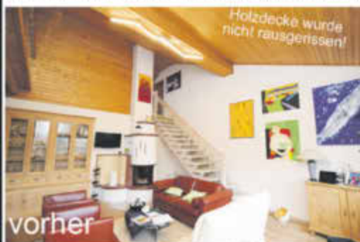
vorher: Wohnzimmer mit Holzbalken und Holzdecke. Die Decken waren gut erhalten und konnten somit als Unterkonstruktion wiederverwendet werden.
