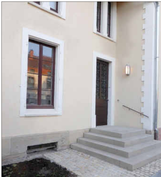
Der neue Eingangsbereich ist bereits fertiggestellt - restaurierte Tür, neue Treppe
