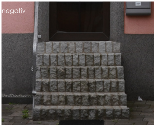
Treppe aus Fertigteilen
