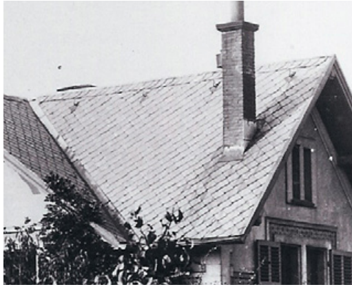
Schieferdeckung am ehemaligen Rathaus
