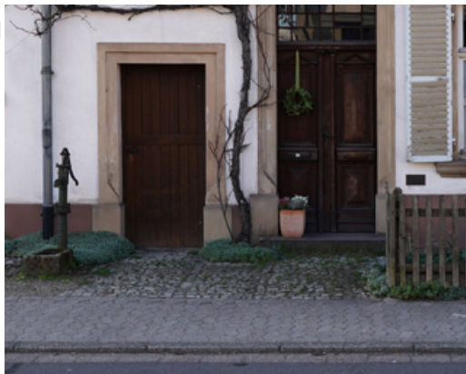
Verwendung historisches Pflaster
