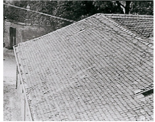
Deckung mit Biberschwanzziegeln
