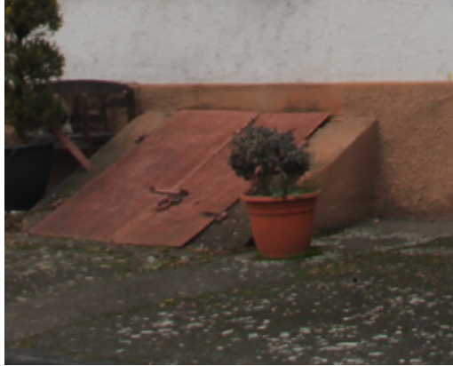
Kellerloch mit Zugang
