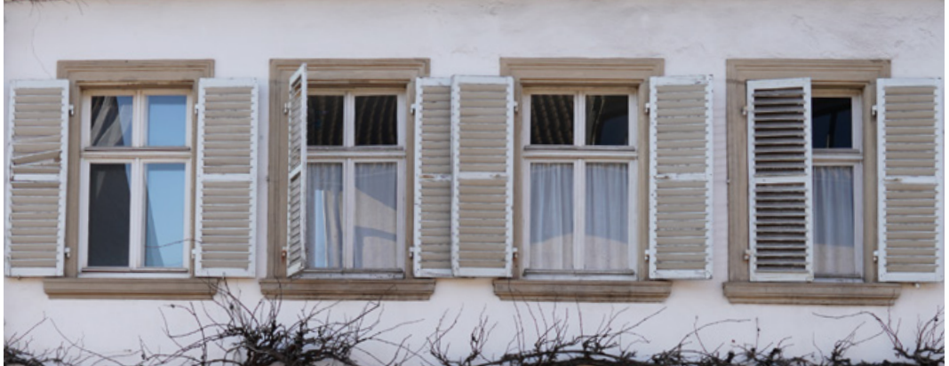
historisch intakte Fensterläden die mit wenig Aufwand saniert werden könnten
