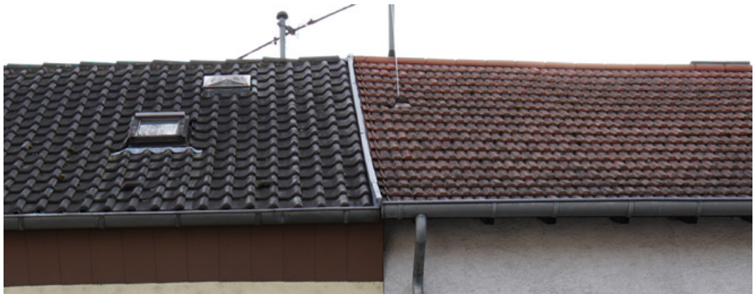
rechts traditionelle Deckung mit Naturroten Falzziegeln, links ortsuntypische Deckung
