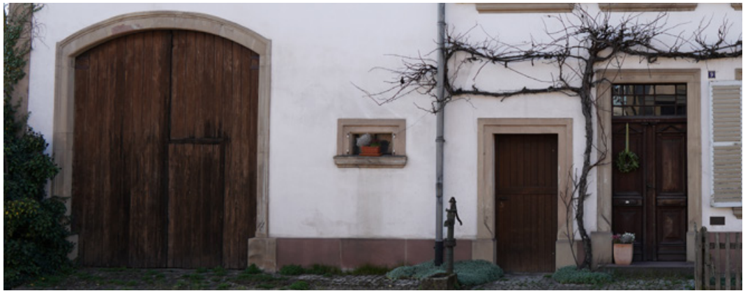
Scheunentor eines instandgehaltenen Bauernhauses
