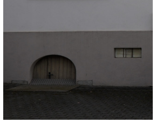
Kellerloch mit Holztür
