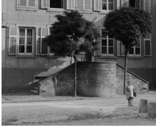
Treppe Sonnenstraße um 1885
