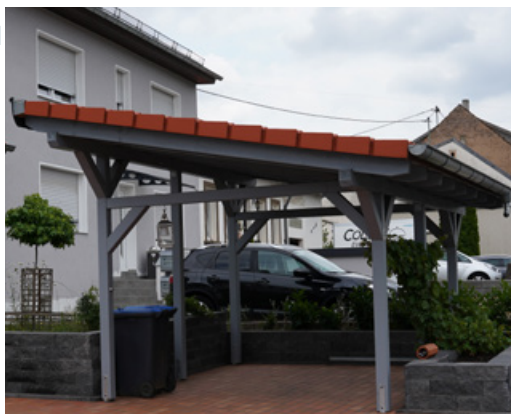
Carport mit Ziegeleindeckung
