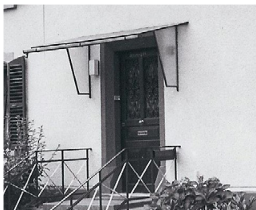
Vordach in leichter Konstruktion
